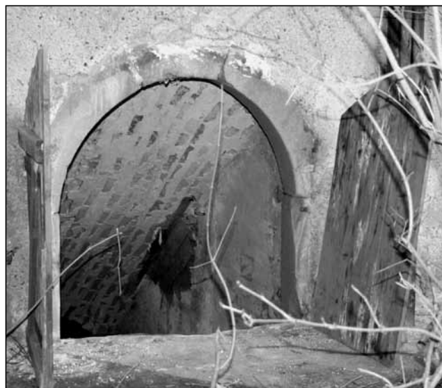
Kamenný portál vstupu do suterénu, foto 2009
