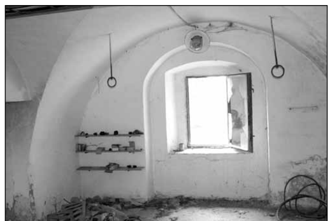
Dřívější spíž v přízemí, foto 2009.
