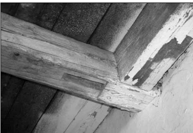
Stropní trám vyrobený ze starého krovu v patře, foto 2009.
