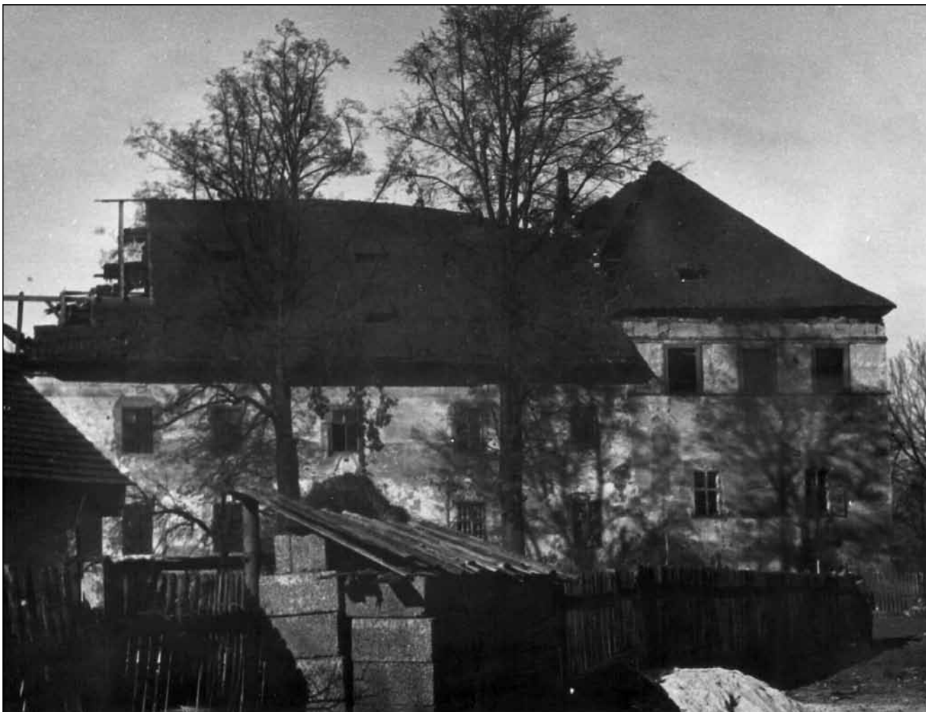
Bývalý zámek v Petřvaldě – průčelí s hlavním vchodem a střechou částečně poškozenou vichřicí (Foto z archivu obce Petřvald).
