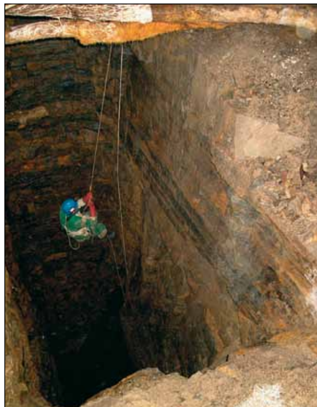
Důl František (také Olověný). Pohled do asi 70 metrů hluboké šachtice, která vede na spodní patra dolu.
